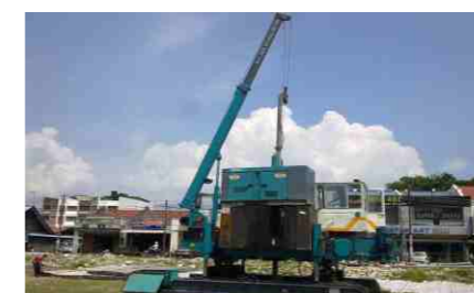
马来西亚施工 Construction scene in Malaysia
